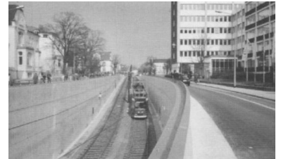
Die Betonrampe ist zwar häßlich, aber sie dokumentiert ÖV-freundliche Stadtplanung. (Foto: Arthur Frenzel)
