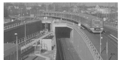
Ab 1. Januar 2004 werden bei der Hamburger und bei der Berliner S-Bahn über 40% mehr Trassenentgelte fällig (hier die Hamburger S-Bahn). (Foto: DB AG, Jazbec)
