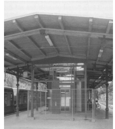
Am 15. August soll nun endlich auch der Aufzug auf dem S-Bahnhof Nikolassee in Betrieb genommen werden. (Foto: Frank Böhnke)
