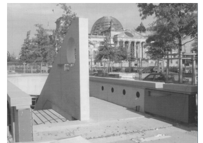
Unützer Beton im Berliner Sand: der U-Bahnhof Reichstag. (Foto: Florian Müller)
