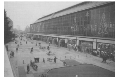
Dircksenstraße: Viel Platz für die zweite Straßenbahn zum Bahnhof Alexanderplatz. (Foto: Alexander Frenzel)
