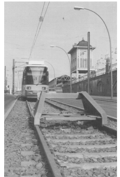
400 Meter Neubaustrecke an der Oberbaumbrücke. (Foto: Alexander Frenzel)
