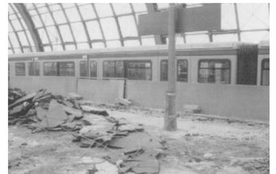
Am Lehrter Bahnhof fahren die S-Bahnen ohne Halt durch. Beim Bau wurde wegen künstlich erzeugtem Termindruck nur ein provisorischer Bahnsteigbelag aufgebracht. Dieser wird jetzt ganz langsam im Einschiebtetrieb und unter Heiligung des Wochenende ersetzt. (Foto: Florian Müller)
