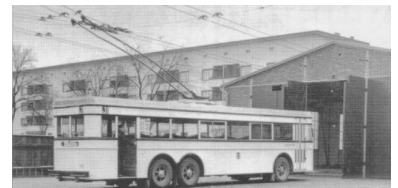
Wagen 1001 vor der Wagenhalle in Spandau. (Foto: Mattis Schindler, DVN)
