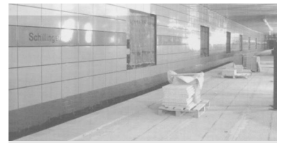
Der sanierte U-Bahnhof Schillingstraße einen Monat vor der Wiedereröffnung im November 2003. (Foto: Florian Müller)
