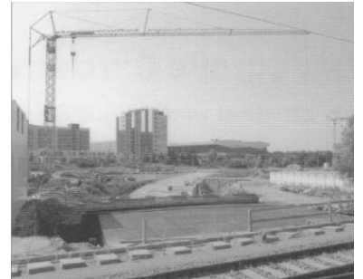
Baustelle Rostock Hauptbahnhof mit der zukünftigen Straßenbahn-Trasse. (Foto: Alexander Frenzel)
