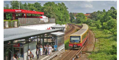
S-Bahnhof Heidelberg Platz am Südring. Neben dem S-Bahn-Zug ist eines der beiden zugewachsenen Südring-Fern-/Gütergleise zu erkennen. Das zweite Gleis ist unter Gestrüpp unsichtbar. Die Wiederinbetriebnahme dieser Gleise ist verschoben, und die Elektrifizierung mit Oberleitung abgesagt. (Foto: Florian Müller)
