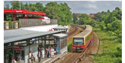
S-Bahnhof Heidelbergberger Platz am Südring. Neben dem S-Bahn-Zug ist eines der beiden zugewachsenen Südring-Fern-/Gütergleise zu erkennen. Das zweite Gleis ist unter Gestrüpp unsichtbar. Die Wiederinbetriebnahme dieser Gleise ist verschoben, und die Elektrifizierung mit Oberleitung abgesagt. (Foto: Florian Müller)
