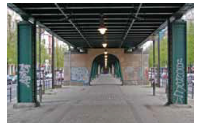
Klobig und monumental wirkt der Unterbau des Hochbahnhofs Eberswalder Straße. Einen eleganteren Eindruck erweckt, durch die Schrägstellung der Stützen, der eiserne Viadukt. Die 1930 eröffnete Verlängerung wurde hingegen betont schlicht und sachlich gestaltet (im Hintergrund der alte Viadukt, der an der heutigen Kreuzung Paul-Robeson-/Erich-Weinert-Straße endet). (Foto: Jan Gympel)
