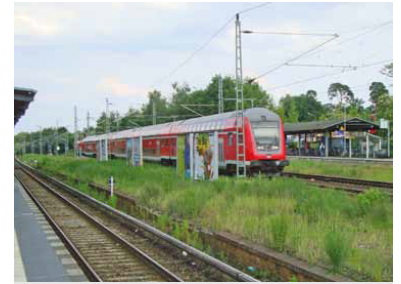
Kein Halt in Griebnitzsee für Regionalzüge zwischen Berlin und Potsdam. Auf der bewachsenen Fläche des ehemaligen Bahnsteigs im Vordergrund soll der zweite Regionalbahnsteig entstehen - leider frühestens 2015 und damit viel zu spät. (Foto: Florian Müller)
