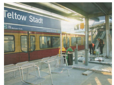
Auf dem S-Bahnhof Teltow Stadt führen die Bauarbeiter zwei Wochen vor der Eröffnung letzte Handgriffe aus. Die Probefahrten laufen zur gleichen Zeit an. (Foto: Marc Heller)
