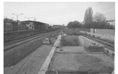
Bahnhof Charlottenburg, Blick nach Westen. Das Foto vom Dezember 2004 zeigt den neuen Bahnsteig D mit dem Rohbau des Treppenabgangs zur Lewishamstraße und Strecken- und Betriebsgleisen (Gleiswechsel und zweigleisige Kehranlage). (Foto: Florian Müller)
