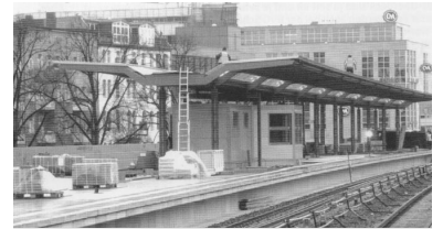
Der Bahnsteig D des zur Wilmersdorfer Straße verschobenen S-Bahnhofs Charlottenburg ist jetzt im Rohbau fertig und soll im Juni 2005 in Betrieb genommen werden. Dann beginnen der Abbruch und Neubau des Bahnsteigs C. Durch die Verschiebung verkürzt sich der Umsteigeweg zwischen S-Bahn und U-Bahn (U 7) erheblich. Unbegreiflich aber ist, daß die neuen Bahnsteige nur zur Hälfte überdacht werden, obwohl auf dem verlegten S-Bahnhof künftig fast 50.000 Fahrgäste pro Werktag erwartet werden. (Foto: Florian Müller)
