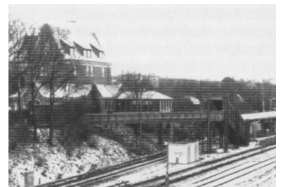
Hamburg, S-Bahnhof Rübenkamp. Seit Jahren erreichen die Fahrgäste den Bahnsteig nur über einen ungedeckten Holzsteg. Auch die Berliner Fahrgäste am S-Bahnhof Warschauer Straße werden nun für viele Jahre ohne Witterungsschutz zum Bahnsteig laufen müssen. (Foto: Jan Gympel, 1999)
