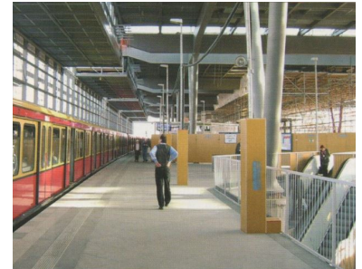
Beeindruckende Dimensionen. Seit dem 4. April halten die Züge der S 41 im neugebauten Bahnhof Papestraße in der Ringbahnhalle. (Foto: Florian Müller)
