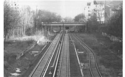
Unter der Brücke soll Anfang 2007 der S-Bahnhof Kolonnenstraße in Betrieb gehen - wenn nichts dazwischen kommt. Die beiden S-Bahngleise bekommen Außenbahnsteige. Das Logistik-Gütergleis rechts wird verschoben und kann später für die Stammbahn nach Düppel genutzt werden. Links die alte Bahnsteigkante des Ringbahnhofs. Blick Richtung Süden auf die Julius-Leber-Brücke. (Foto: Florian Müller)
