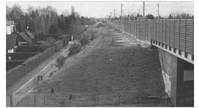
An der Hackbuschstraße in Spandau ist der Bahndamm für die S-Bahn nach Falkensee/Finkenkrug schon vorbereitet. Zur besseren Erschließung des Spandauer Westens einschließlich der Großsiedlung Falkenhagener Feld sind drei neue S-Bahnhöfe sinnvoll. Dafür könnte der heutige Regionalbahn-Haltepunkt Albrechtshof aufgegeben werden. (Foto: Florian Müller)
