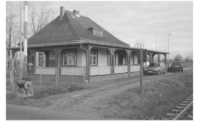
Im Bahnhof Raddusch im Spreewald sollen wieder regelmäßig die Züge der RE-Linie 2 halten - zusätzlich zu dem 2004 neu eingerichteten Tropical Islands - Halt in Brand. (Foto: Florian Müller)
