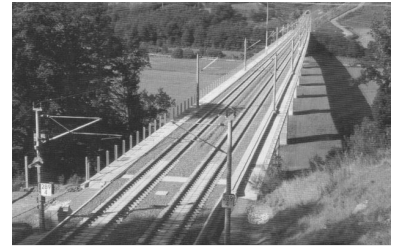
Eine deutliche Fahrzeitverkürzung ist in den Mittelgebirgen in der Regel nur mit einer Neutrassierung möglich. Neubaustrecke Hannover--Würzburg bei Fulda. (Foto: Christian Schultz)
