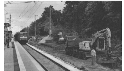
Ein beschleunigter Ausbau der Infrastruktur wäre eine Voraussetzung, um zwischen Deutschland und Polen deutlich mehr Güter von der Straße auf die Schiene zu verlagern. Aber selbst auf dieser wichtigen Magistrale zwischen Berlin Ostbahnhof und Frankfurt (Oder) werden die Arbeiten nach dem derzeitigen Planungsstand frühestens im Jahr 2009 abgeschlossen werden. (Foto: Christian Schultz)
