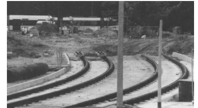
Straßenbahn-Neubaustrecke am Nordbahnhof. Im Hintergrund ist die Straßenbahn auf der Invalidenstraße zu sehen. Unverständlicherweise bekommen die neuen Gleise hier auf Jahre keinen Anschluss an das bestehende Netz. (Foto: Alexander Frenzel)
