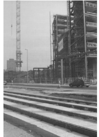
Kein Anschluss auf diesen Gleisen. 2006 sollte die Straßenbahn zum Lehrter Bahnhof fahren. Damit hätte es gut 16 Jahre nach dem Mauerfall endlich die zweite sektorenüberschreitende Straßenbahnstrecke in den Westteil Berlins gegeben. Zwar wurden auf der Invalidenstraße am künftigen Hauptbahnhof inzwischen die ersten Gleise gelegt, doch frühestens 2010 werden hier die Züge vom Nordbahnhof ankommen. (Foto: Florian Müller)
