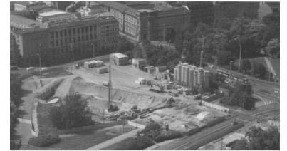
Baustelle für den künftigen Tunnelbahnhof Wilhelm-Leuschner-Platz im Mai 2005. (Foto: Joachim Schmitt)
