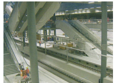
Fahrtreppen auf den Tunnelbahnsteigen. Von den unteren zu den oberen Bahnsteigen sind vier Ebenen zu überwinden (Foto: Florian Müller, November)
