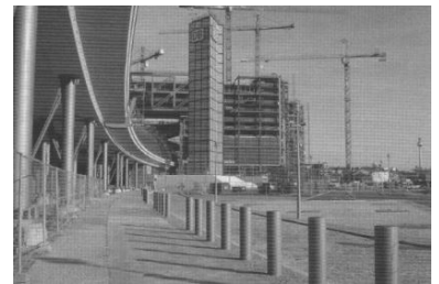
Der südliche Bahnhofsvorplatz (Washingtonplatz) ist schon teilweise fertiggestellt. Die Busse und später die Straßenbahnen werden aber zentral an der Nordseite in der Invalidenstraße abfahren. (Foto: Florian Müller)
