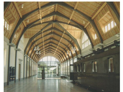
Beeindruckend: Die von der DB AG denkmalgerecht wiederhergestellte prächtige Halle der einstigen Hofstation Wildpark, von den Potsdamer Bürgern Kaiserbahnhof genannt. (Foto: Charlotte Schwalm-Dittfurth)
