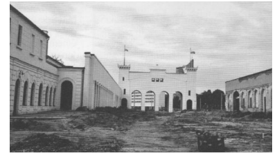
Der ehemalige Kopfbahnhof Bayerischer Bahnhof als Baustelle im Jahr 2005. (Foto: Manuel Schubert)
