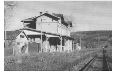
Bahnhof Waldenburg. Die Strecke Glauchau--Großbothen ist seit dem Unwetter im Jahre 2002 komplett außer Betrieb. (Foto: Frank Groß)
