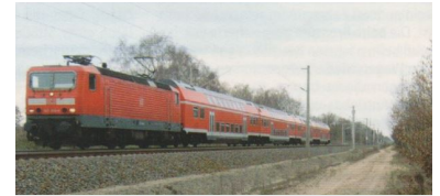
Falkensee, zwischen Bf Falkensee und Finkenkrug. Auch hier im Geländeniveau ist die Trasse für ein S-Bahngleis freigehalten. (Foto: Florian Müller)
