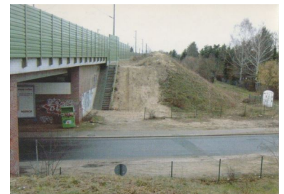
Spandau, Hackbuschstraße. Der Bahndamm für die Verbreiterung um ein oder zwei weitere Gleise ist bereits größtenteils fertig. Die Brückenbauwerke können einfach ergänzt werden. (Foto: Florian Müller)
