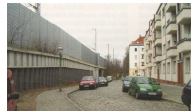
Spandau, Staakener Straße. Hier grenzt die Bahn-Stützwand an einen kaum genutzten Gehweg, den man für eine Verbreiterung für ein S-Bahngleis überbauen kann. (Foto: Florian Müller)
