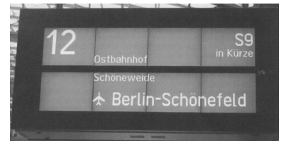
Modern. In Berlin Hauptbahnhof-Lehrter Bahnhof und Papestraße sind LCD-Anzeiger in Betrieb. Die Ausführung mit zwei Anzeigeflächen ist für Fernbahnhöfe vorgesehen. S-Bahnhöfe sollen Anzeiger mit nur einer Anzeigefläche bekommen. Die Gleisnummer soll künftig nicht mehr im Display angezeigt werden, dafür die Halteposition am Bahnsteig. (Foto: Florian Müller)
