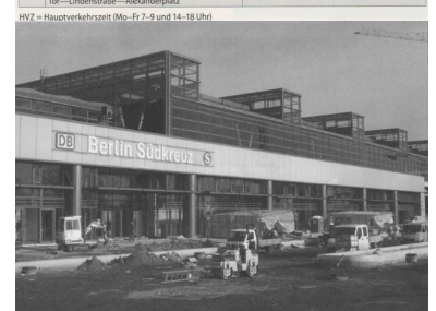
Vom westlichen Bahnhofsvorplatz des neuen Fernbahnhofs Berlin Südkreuz fahren die Buslinien M 46, 106 und 204. Die Ringbahnhalle präsentiert sich als gläserner Kasten. (Foto: Florian Müller)
