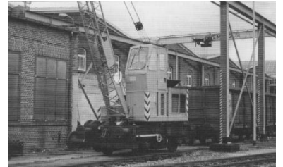
Für den Erhalt der historischen Eisenbahnwerkstätten in Zwickau setzt sich die BSW Freizeitgruppe »Historische Werkstätten und Eisenbahntechnik« ein. (Foto: Andre Ackermann)
