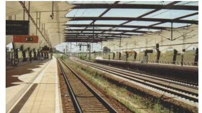
Bahnhof Flughafen Leipzig/Halle an der Aus- und Neubaustrecke Nürnberg--Erfurt--Leipzig/Halle--Berlin (Verkehrsprojekt Deutsche Einheit Nr. 8). Im Abschnitt Nürnberg--Leipzig (VDE 8.1 und 8.2) wurde bislang lediglich dieser 23 km lange Neubaubereich zur Anbindung des Flughafens fertig gestellt. Dieser geringe Baufortschritt ist insbesondere vor dem Hintergrund nicht genutzter Gelder für den Ausbau der Eisenbahninfrastruktur unbegreiflich. Da diese Gelder für die Bahn aber verloren sind, sollte das Projekt nun wenigstens durch eine Modifikation der Planung zwischen Nürnberg und Erfurt beschleunigt werden. (Foto: Christian Schultz, Juli 2006)
