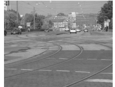
Blick vom Potsdamer Hauptbahnhof Richtung Innenstadt auf die Lange Brücke. Durch eine neue Straßenbahnbrücke in Seitenlage (rechts) soll das Queren der Fahrbahn künftig entfallen, wovon täglich viele tausend Fahrgäste und auch die Autofahrer profitieren würden. (Foto: Frank Böhnke)
