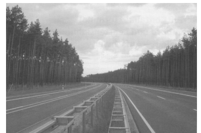
Straßenbau findet in Deutschland offenbar unabhängig vom tatsächlichen Bedarf statt. Foto: Umgehungsstraße bei Oranienburg, autobahnähnlich ausgebaut (Foto: Frank Böhnke)
