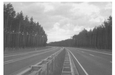
Straßenbau findet in Deutschland offenbar unabhängig vom tatsächlichen Bedarf statt. Foto: Umgehungsstraße bei Oranienburg, autobahnähnlich ausgebaut (Foto: Frank Böhnke)
