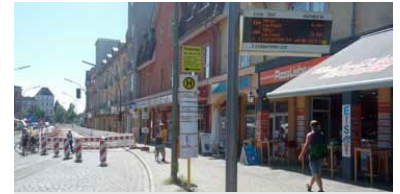
Achtung Bauarbeiten! Ein großes klaffendes Loch und mehr Haltestellenschilder als gewöhnlich lassen beim Kunden mit Fahrgastabitur die Alarmglocken läuten. (Foto: Holger Mertens, 10. Juli 2013)
