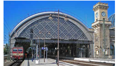
EuroCity von Hamburg nach Budapest in Dresden Hbf. Gerade einmal 6 Minuten schneller werden die Züge, wenn ein Abschnitt der Dresdener Bahn für eine Höchstgeschwindigkeit von 200 statt 160 km/h ausgebaut wird. Aber die Bauarbeiten werden durch diese Änderung erneut verzögert und verteuert. (Foto: Christian Schultz)
