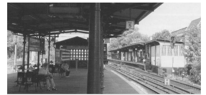
S-Bahnhof Baumschulenweg, alter Mittelbahnsteig und Außenbahnsteig. Der Bahnhof steht zwar unter Denkmalschutz, dennoch werden die Bahnsteige abgerissen und über der Brücke neu aufgebaut. Dabei wird das Dach wiederverwendet. (Foto: Florian Müller)
