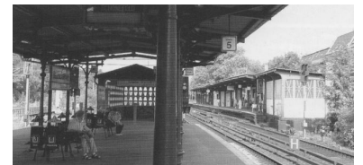
S-Bahnhof Baumschulenweg, alter Mittelbahnsteig und Außenbahnsteig. Der Bahnhof steht zwar unter Denkmalschutz, dennoch werden die Bahnsteige abgerissen und über der Brücke neu aufgebaut. Dabei wird das Dach wiederverwendet. (Foto: Florian Müller)
