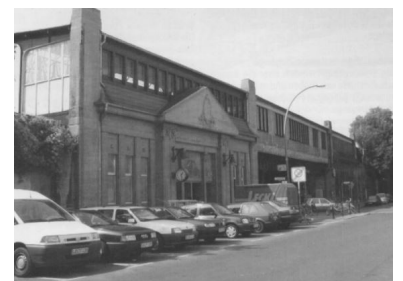
Die denkmalgeschützte Fassade soll fachgerecht restauriert werden. (Foto: Florian Müller)
