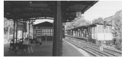
S-Bahnhof Baumschulenweg, alter Mittelbahnsteig und Außenbahnsteig. Der Bahnhof steht zwar unter Denkmalschutz, dennoch werden die Bahnsteige abgerissen und über der Brücke neu aufgebaut. Dabei wird das Dach wiederverwendet. (Foto: Florian Müller)
