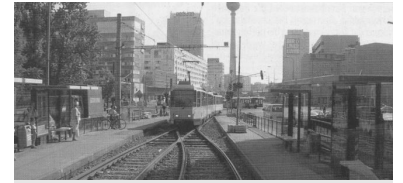
Alles schon mal dagewesen: Gleisprovisorium für Linie 1 Mollstr./Prenzlauer Allee für den ersten Anlauf zum Streckenbau. (Foto: Frank Brunner, August 2003)
