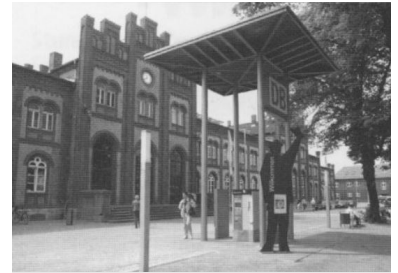
Wie das Empfangsgebäude des Bahnhofs Stendal müssten alle Bahnhofsgebäude aussehen. Leider jedoch beschränkt sich das Engagement der Deutschen Bahn meist nur auf »lukrative« Standorte. (Foto: DB AG/Jazbec)
