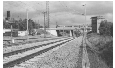
Trotz erheblicher Kürzungen bei den Schieneninfrastruktur-Projekten gesichert: VDE-Projekt 8.3 Berlin - Halle/Leipzig. Aufnahme in Genshagener Heide, Bauzustand September 2004. (Foto: Christian Schultz)
