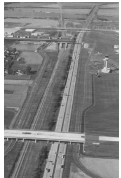
Verkehrsbündelung der Neubaustrecke Halle - Leipzig, Abschnitt Knoten Gröbers - Leipzig im Bereich des Flughafens Leipzig/Halle mit der Autobahn A 14 Magdeburg - Dresden, im Vordergrund eine Rollfeldbrücke zur Verbindung der beiden Flughafenbereiche Nord und Süd über beide Verkehrsträger (VDE 8.2 Neubaustrecke 130 km Erfurt - Leipzig/Halle (ca. 23 km Gröbers - Leipzig mit Flughafenbahnhof Leipzig/Halle in Betrieb). (Foto: DB AG/Busse)
