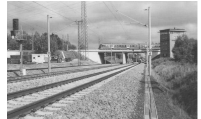
Trotz erheblicher Kürzungen bei den Schieneninfrastruktur-Projekten gesichert: VDE-Projekt 8.3 Berlin - Halle/Leipzig. Aufnahme in Genshagener Heide, Bauzustand September 2004. (Foto: Christian Schultz)
