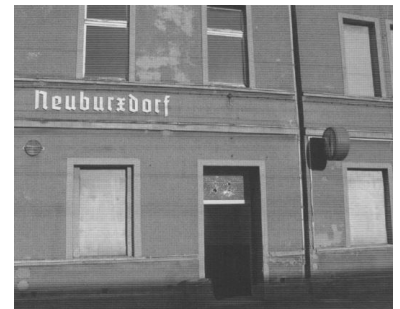
Empfangsgebäude des Bahnhofs Neuburxdorf. Weil Sachsen die Verbindung Falkenberg - Riesa abbestellen will, droht dem brandenburgischen Neuburxdorf, dass ab dem 12. Dezember hier keine Züge mehr halten. Aber es gibt noch Anlass zu Hoffnungen (siehe Seite 30). (Foto: Florian Müller)
