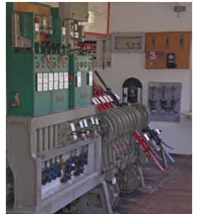
Die mechanische Stellwerkstechnik arbeitet seit Jahrzehnten zuverlässig und sicher, hier im Bf. Bischofswiesen; der Betrieb ist jedoch personalintensiv. (Foto: Christian Schultz)
