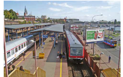
Bahnhof Szczecin Główny (Stettin Hbf). Der DB-Regio-Dieseltriebwagen (BR 628) aus Angermünde fährt bis Passow unter DB-Fahrleitung (15 000 V, 16 2/3 Hz), dann 30 km ohne Oberleitung in Deutschland, 10 km ohne Oberleitung in Polen und ab Bahnhof Szczecin Gumience unter PKP-Fahrleitung (3000 V =). (Foto: Florian Müller)
