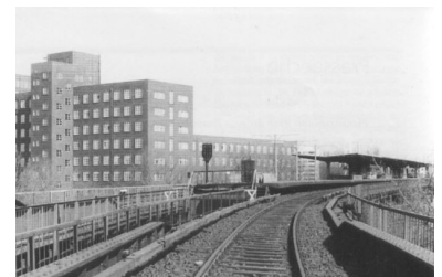
S-Bahnhof Wernerwerk 1984 mit Siemensbauten aus den 20er Jahren (Architekt Hans Hertlein). (Foto: Udo Dittfurth)
